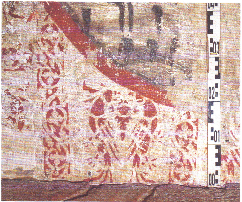
Detail des unteren Abschlusses der Wandmalereien in Form von schablonierten Vogelmotiven und Maßwerkformen.
